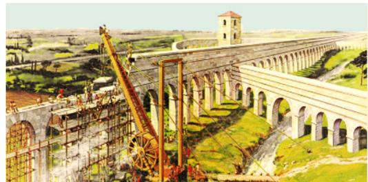
FIG. 12 Costruzione degli Acquedotti che si incrociano al Fiscale. I blocchi costituenti il condotto stagno dove scorreva l'acqua venivano sollevati con la machina tractoria e posizionati al di sopra delle arcate.
